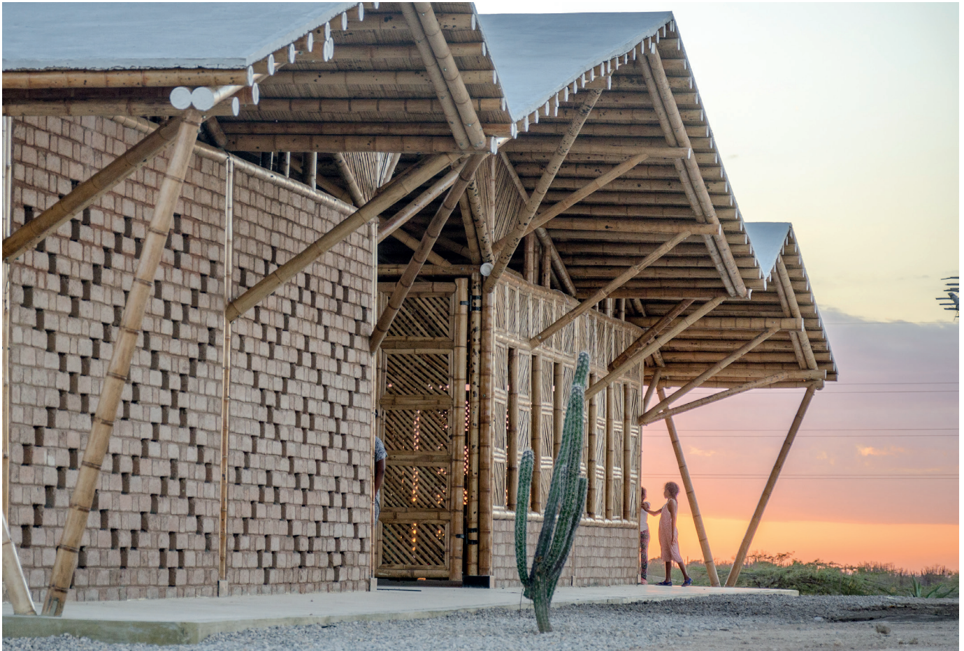
Figura 3_ Vista fachada principal y cubierta plegada.
