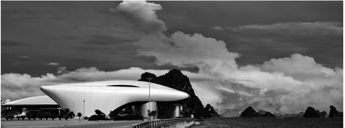
Figura 30_ Vista oeste del proyecto.
