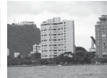
Edificio Seguros Bolívar (ca. 1965) mirando hacia el sur-oeste. Se aprecia la piscina a nivel de la plataforma. Esta fachada contiene los corredores de acceso, las habitaciones del segundo piso y se enfrenta perpendicularmente a la dirección dominante del viento. Fototeca de Cartagena Junio 2007.
