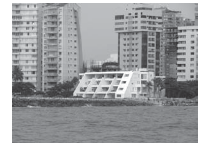
Edificio El Laguito, Boca Grande, Cartagena. Fotografía de Oscar Prieto 2007.
