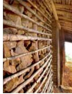
14. Ejemplo de construcción en bahareque: es una estructura en madera (pórticos) que realiza todo el esfuerzo de la construcción. Para hacer los muros se utiliza esterilla de guadua o caña brava, que se va colocando entre columnas, a lado y lado de la estructura, de abajo hacia arriba, y se va relleno el interior con piedra y barro. Una vez se construye todo el muro, se aplica tierra en estado plástico para emparejar el muro. Se deja secar y luego se le aplica el pañete.
