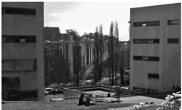
Figura 13. Espacio urbano: relaciones espaciales, compositivas y visuales entre edificios y espacios libres. Fontana, 2009.
