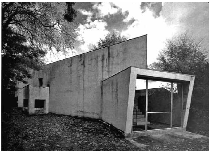
Figura 9. Vista de la solución de la entrada. Fuente: El Croquis n.º 64/65, 1994.
