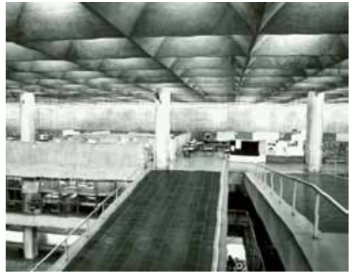
Figura 12. Rampas. Fuente: FAU/USP.
