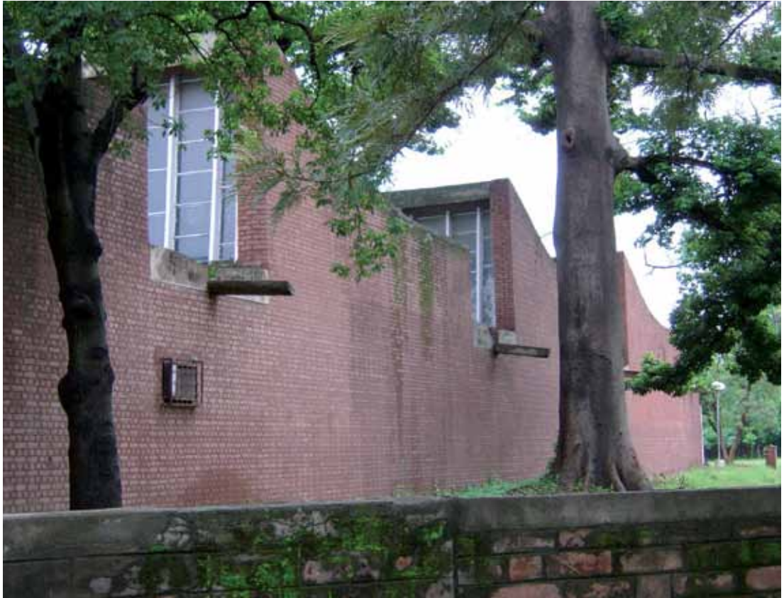
Figura 35. Le Corbusier. Escuela de Arte de Chandigarh (1959): fotografía de la fachada occidental. El edificio es cerrado hacia esta cara; solo las gárgolas que desaguan hacia el exterior sobresalen. La curvatura de la cubierta responde a los ventanales que buscan la luz norte. ©María Cecilia O'Byrne, 2004.
