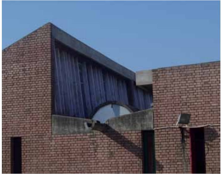
Figura 36. Le Corbusier. Escuela de Arquitectura de Chandigarh (1961): la curvatura de la cubierta, su inclinación y traslapes, resuelven por medio de ventanas y bóvedas la iluminación natural de los espacios interiores. ©María Cecilia O'Byrne, 2008.
