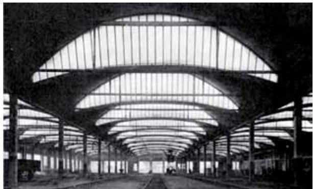
Figura 17. Eugène Freyssinet. Fábrica para la Compañía Nacional de Radiadores en Dammarie-les-Lys (1928): vista a contraluz de uno de los hangares. ©L'Architecture Vivante.
