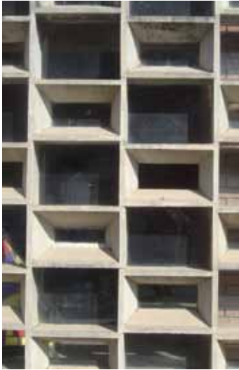
Figura 29. Le Corbusier. Escuela de Arquitectura de Chandigarh (1961): cara exterior de la celosía en concreto ubicada en la fachada sur, que forma una retícula continua en la vertical y discontinua en la horizontal. ©María Cecilia O'Byrne, 2008.
