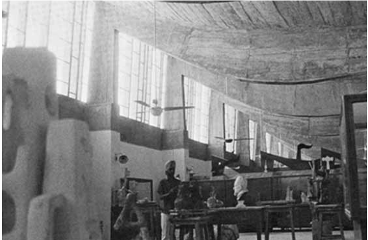
Figura 11. Le Corbusier. Escuela de Arte de Chandigarh (1959): fotografía desde el interior de los talleres de arte. El espacio está iluminado por luz natural proveniente del norte. ©FLC-ADAGP, París. Œuvre complète .
