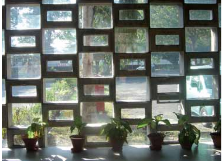
Figura 30. Le Corbusier. Escuela de Arquitectura de Chandigarh (1961): cara interior de la celosía en concreto ubicada en la fachada sur. En esta cara, debido a la forma cónica interior del prefabricado, los vanos son de dos tamaños y se disponen alternadamente. ©María Cecilia O'Byrne, 2008.
