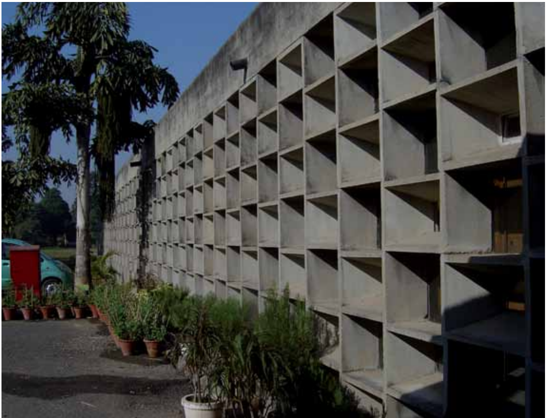
Figura 31. Le Corbusier. Escuela de Arquitectura de Chandigarh (1961): la celosía en concreto a lo largo de la fachada sur. ©María Cecilia O'Byrne, 2008.
