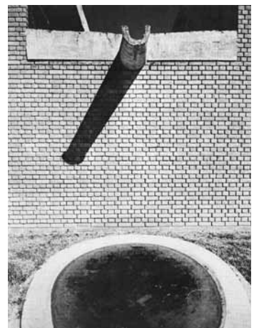
Figura 33. Le Corbusier. Escuela de Arte de Chandigarh (1959): gárgola sobre el patio que vierte el agua en un estanque de planta circular. ©FLC-ADAGP, París. Œuvre complète .
