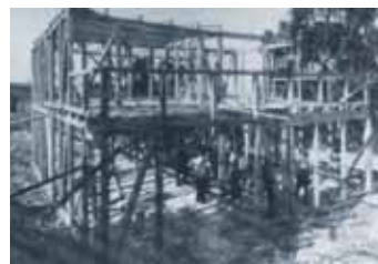
Figura 4. Esqueleto en madera durante la obra de la casa 20, de Hans Poelzig (1927)
