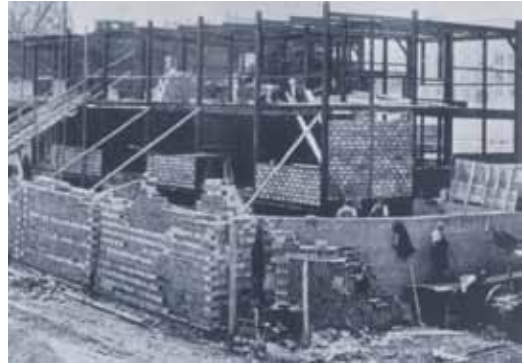
Figura 15. Obra de la casa 1-4, de Mies van der Rohe. Una vez montado el esqueleto, se cierra con bloques tipo remy (1927)
