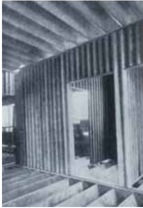
Figura 6. Obra de la casa 18 de Ludwig Hilberseimer. Se utilizan diferentes espesores en el sistema Feifel Zick-Zack, para los muros de carga, los tabiques divisorios y los entrepisos (1927)
