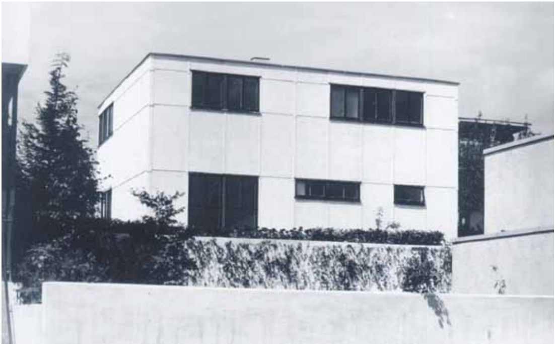
Figura 10. Exterior de la casa 17, de Walter Gropius. La modulación constructiva se refleja en la forma y el volumen (1927)
