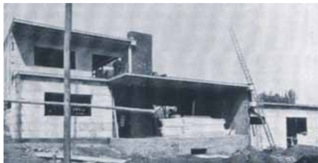
Figura 11. Exterior de la casa 24, de Max Taut. El sistema constructivo permite realizar volúmenes curvos gracias al esqueleto metálico (1927)
