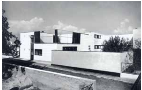
Figura 17. Exterior casa 11, de Adolf Schneck. Los bloques marcan la modulación de la vivienda y, por lo tanto, el orden y el tamaño de sus vanos (1927)
