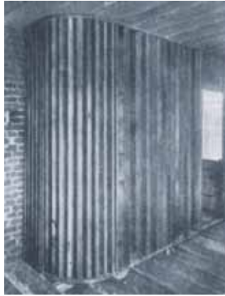
Figura 6. Obra de la casa 18 de Ludwig Hilberseimer. Se utilizan diferentes espesores en el sistema Feifel Zick-Zack, para los muros de carga, los tabiques divisorios y los entrepisos (1927)
