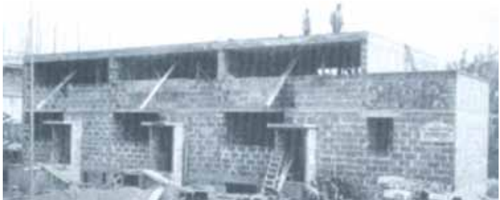
Figura 25. Obra de las casa 28 a 30, de Mart Stam. El exterior de la obra muestra cómo los cerramientos en bloque aligerado protegerán el esqueleto en acero del interior (1927)
