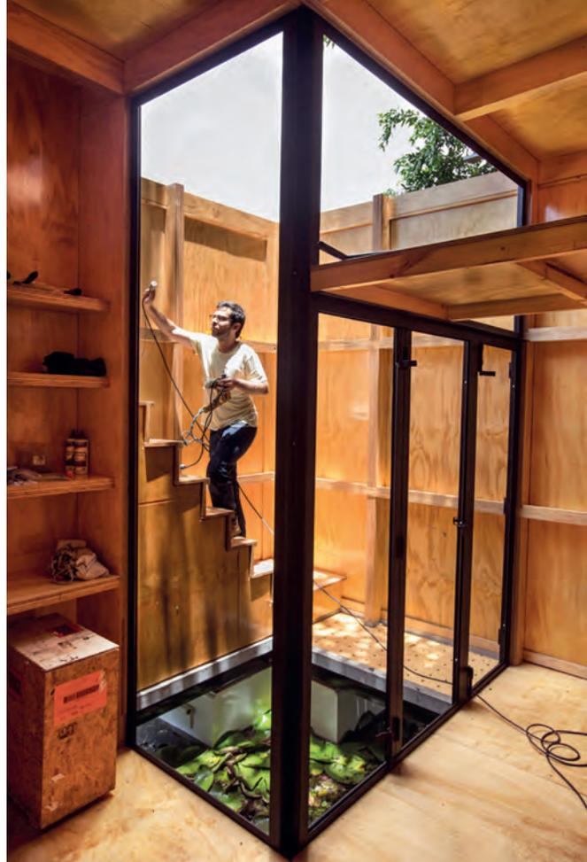
El interior de la caja es en realidad un paralelepípedo que reposa sobre una estructura de 4 x 4 luces y que solo se termina de conformar como cubo en alzado con la presencia de la baranda de la cubierta terraza, a la cual se sube tanto por la escalera interior como por una de gato en metal que está colocada sobre uno de los costados ciegos de la caja, hasta formar la baranda que rodea la terraza, que es el lugar desde donde se vincula la casa con el entorno.
