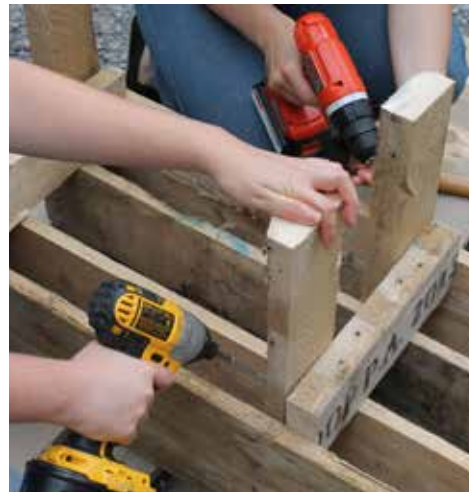
Construcción del banco
