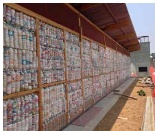
5000 ecoladrillos para la realización de la escuela.
