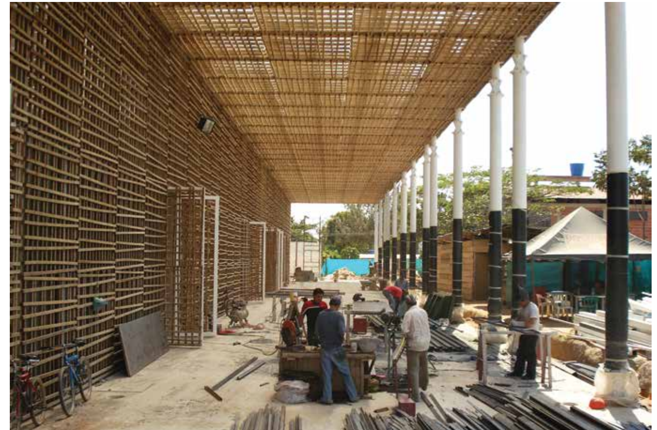
Proceso constructivo de las fachadas
