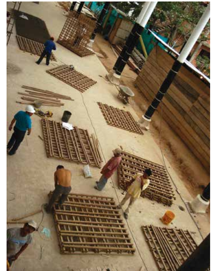
Elaboración de los módulos de la fachada
