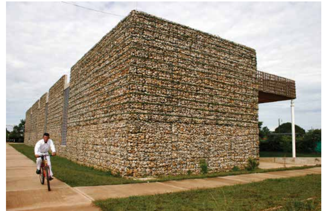
Imagen del edificio terminado
