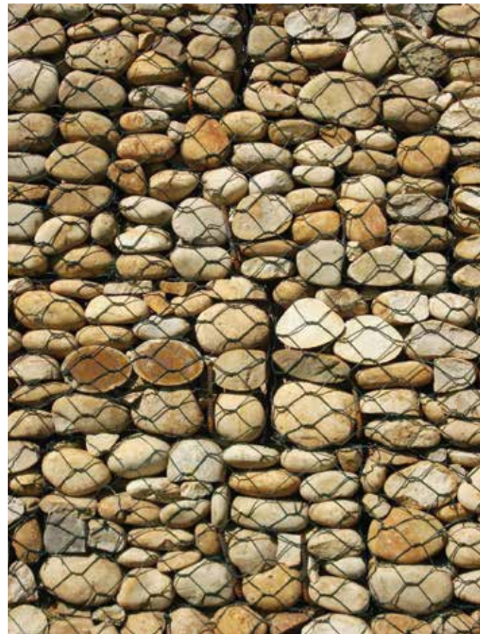
Gaviones y proceso constructivo
