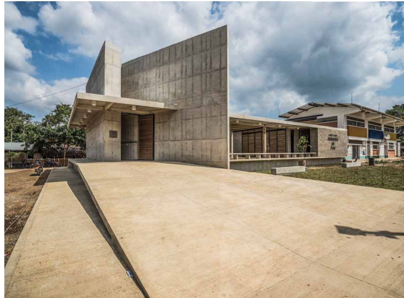
Rampa de acceso.
