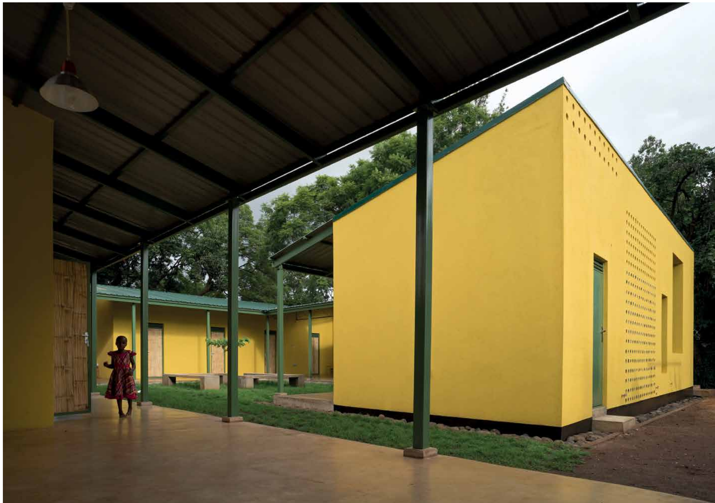
Circulación y patio interior
