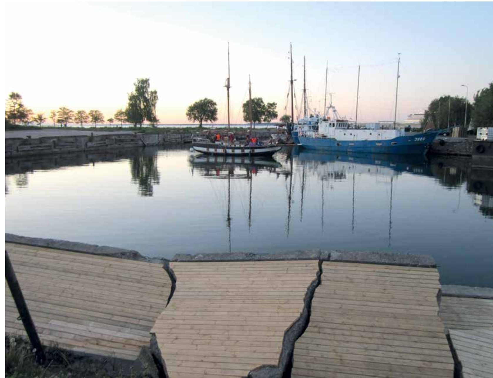
La instalación y su entorno
