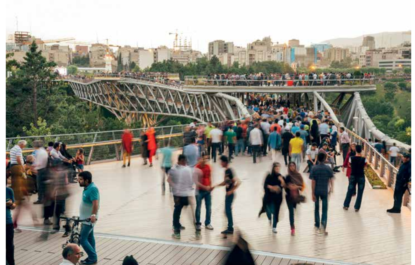
Intensa actividad en el puente peatonal
