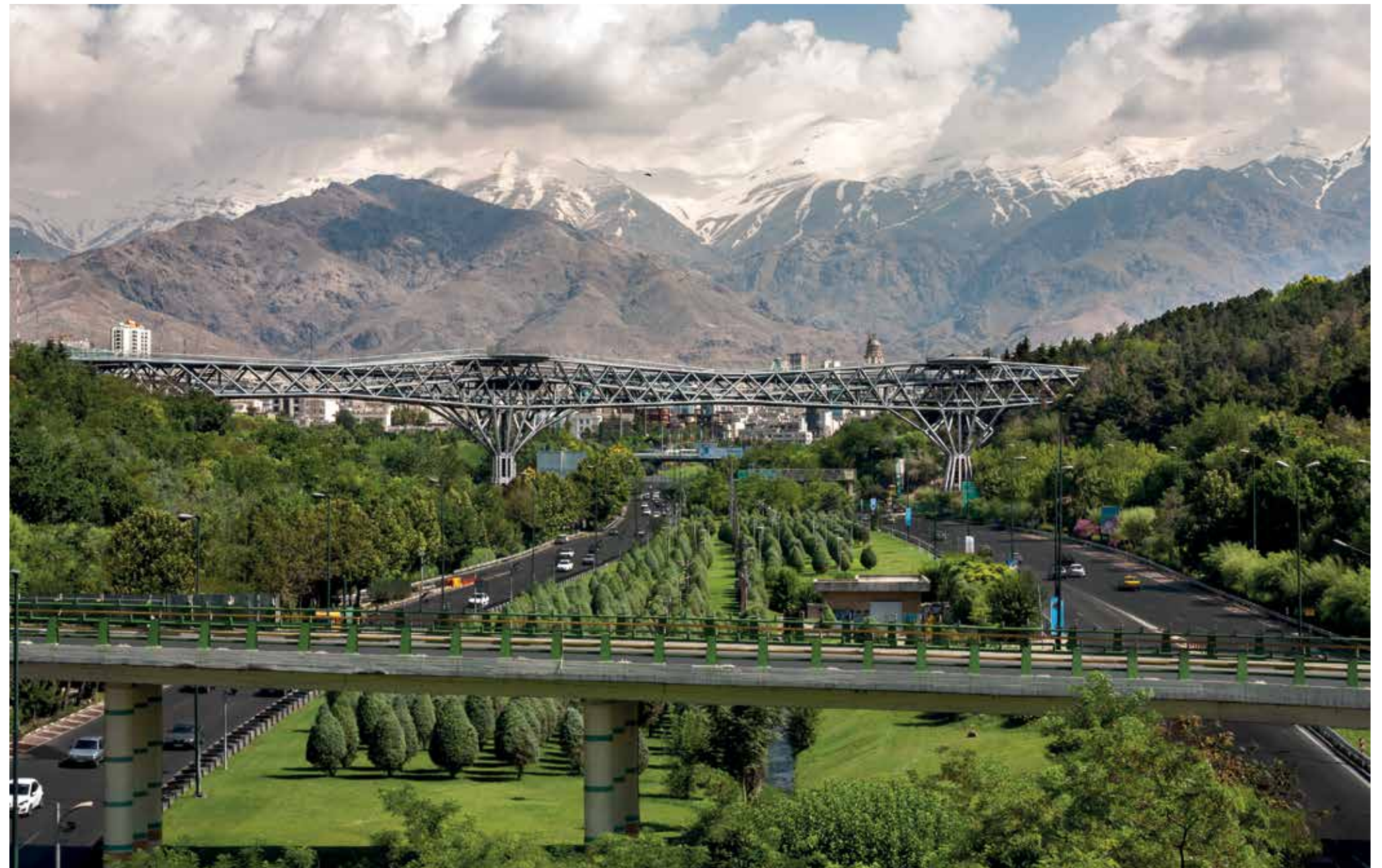
El puente y su entorno
