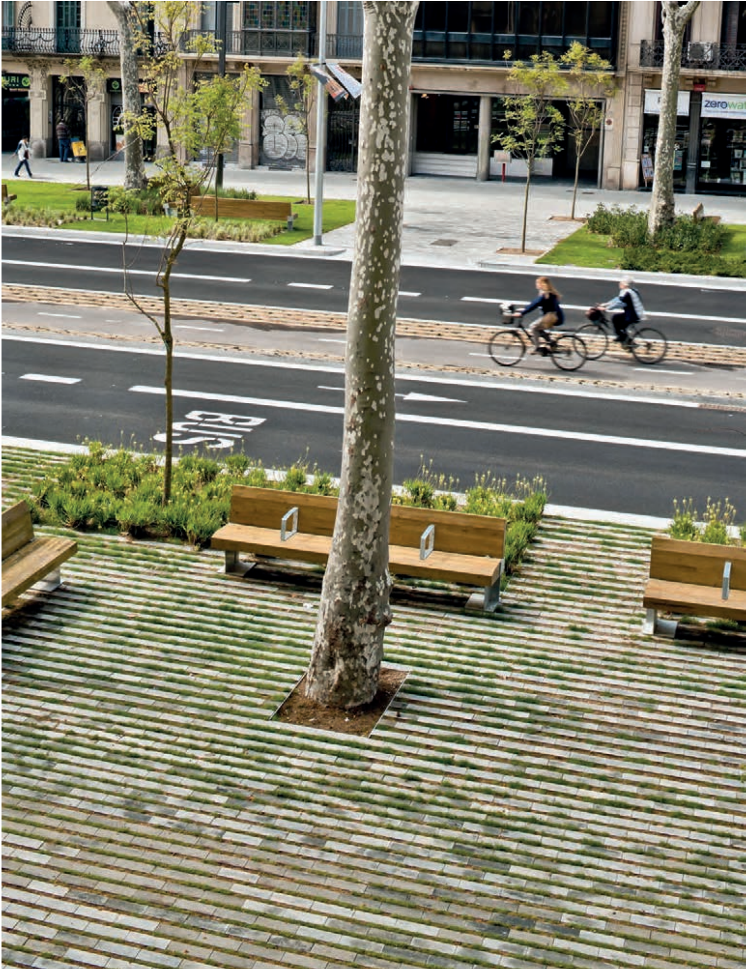
Terrazas. Suelo permeable
