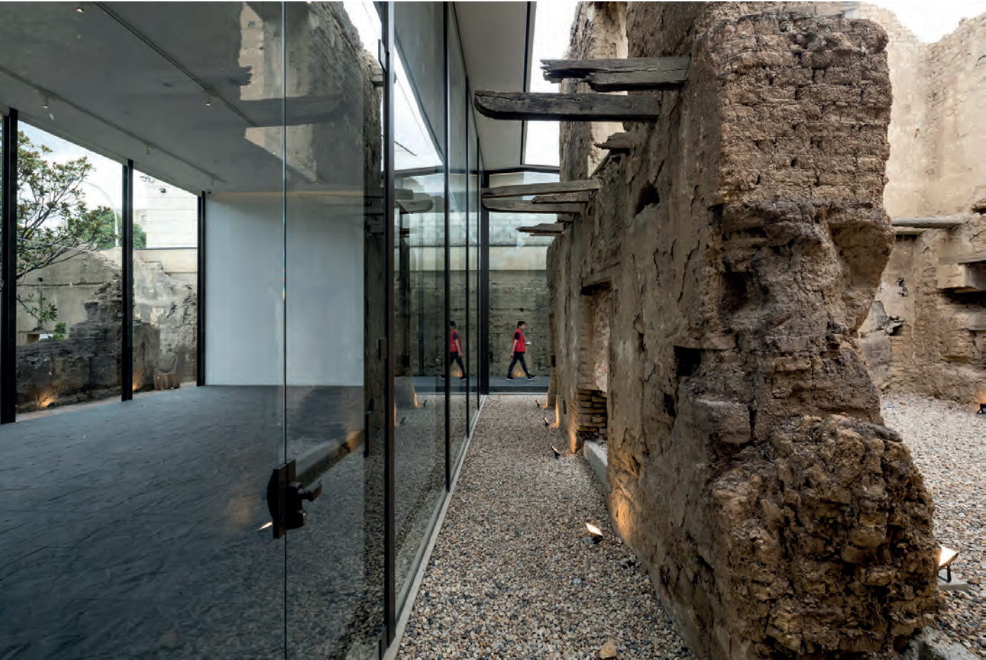
Cerramiento sala No.1
