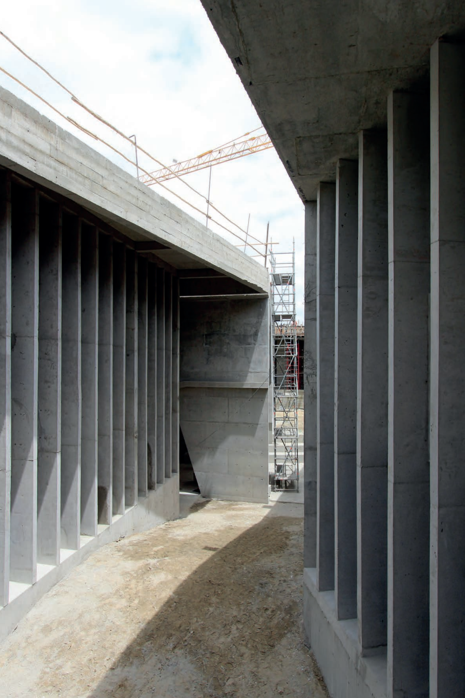
Fachadas en construcción
