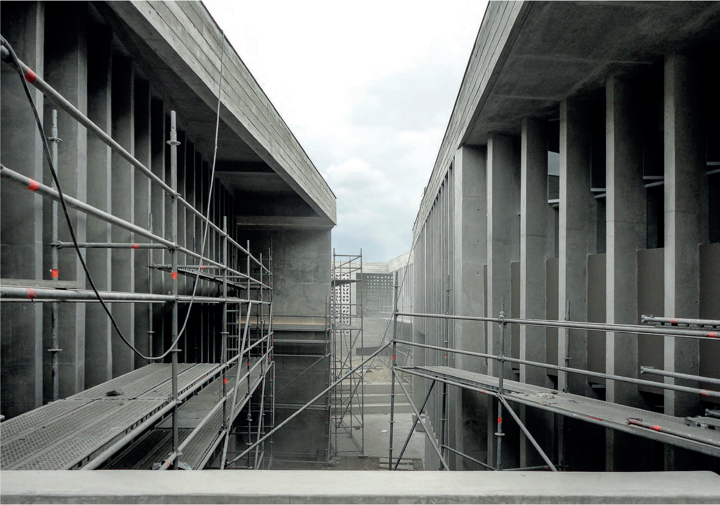
Fachadas en construcción
