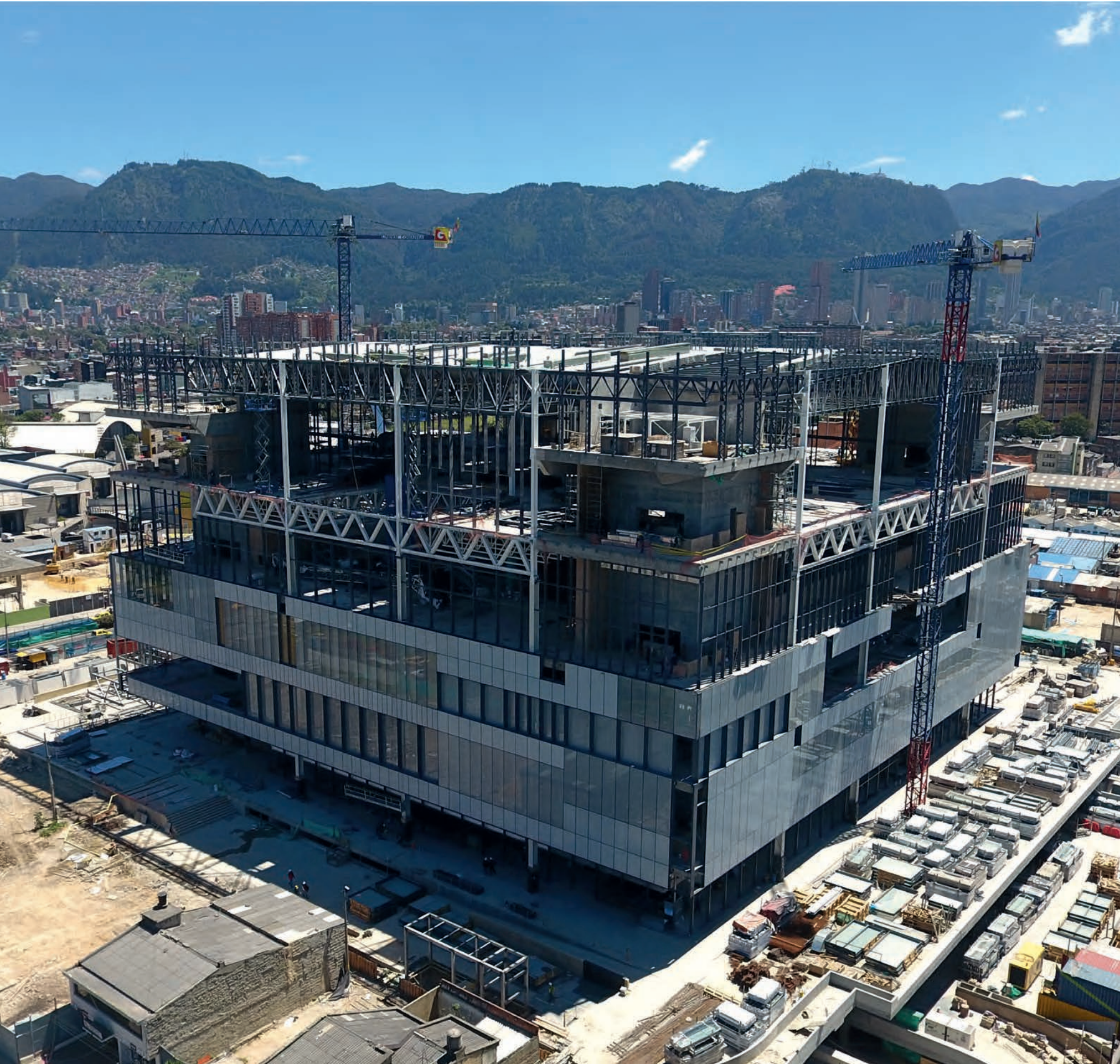
Cerramiento en construcción. ©Bermúdez Arquitectos
