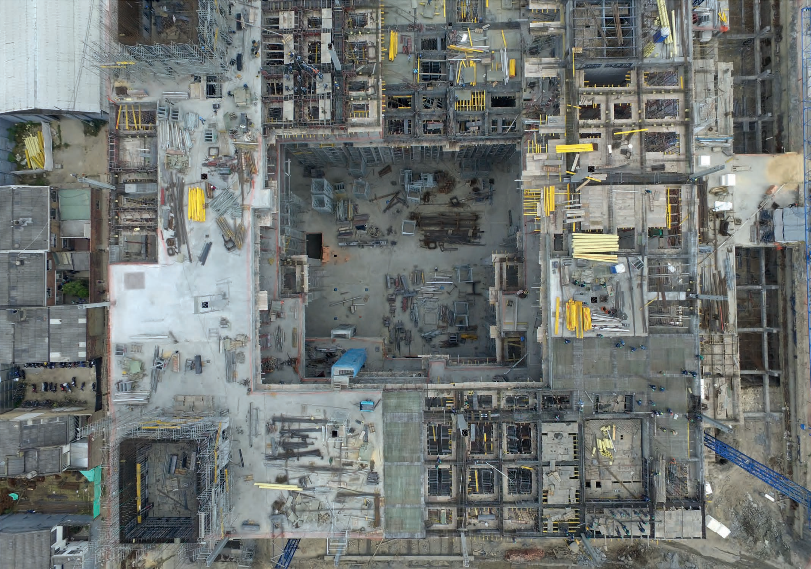
En obra. ©Bermúdez Arquitectos
