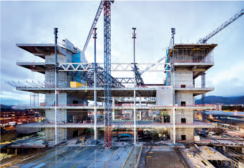
Estructura en construcción. ©Javier Callejas / javiercallejas.com
