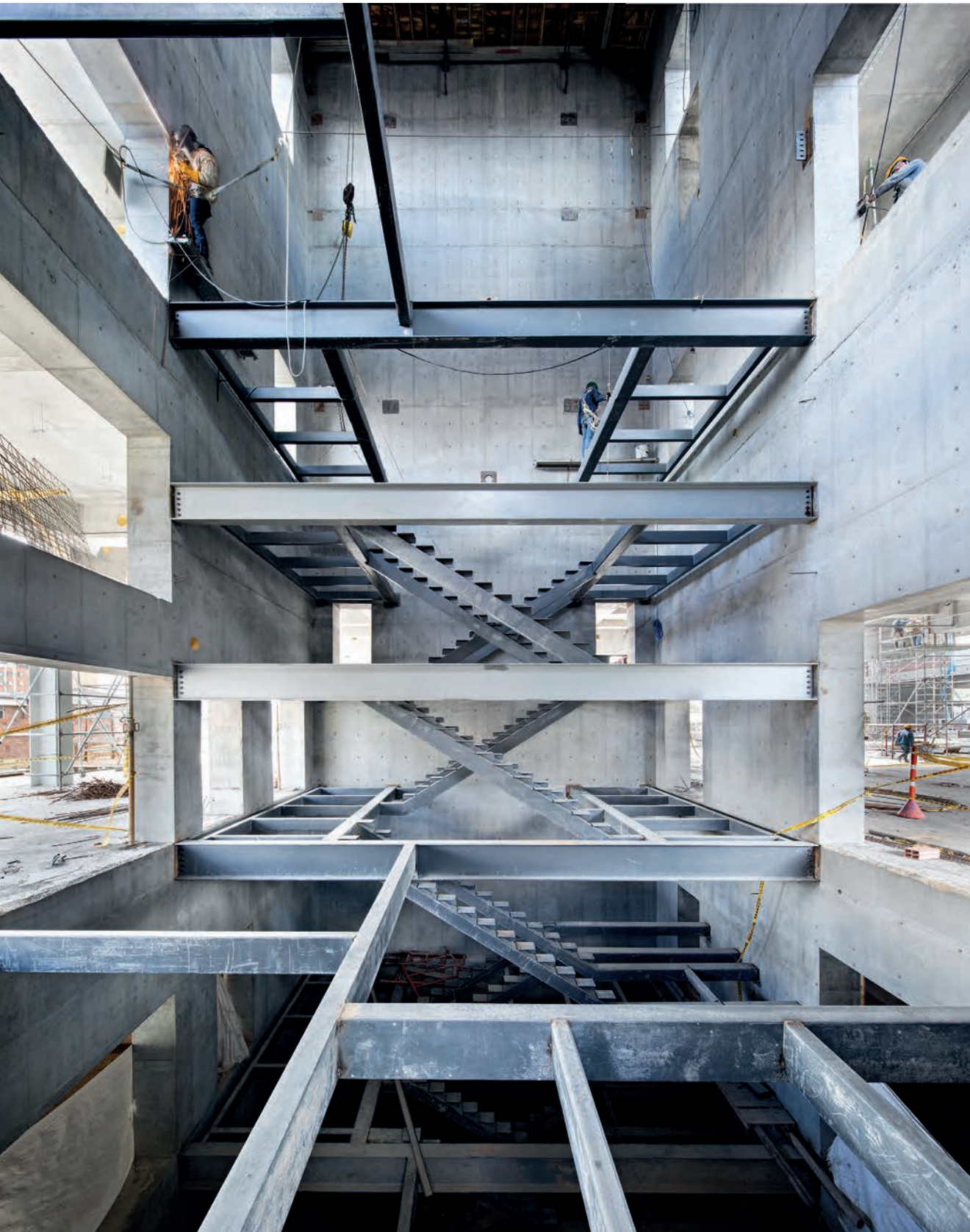
Escaleras en construcción. ©Javier Callejas / javiercallejas.com
