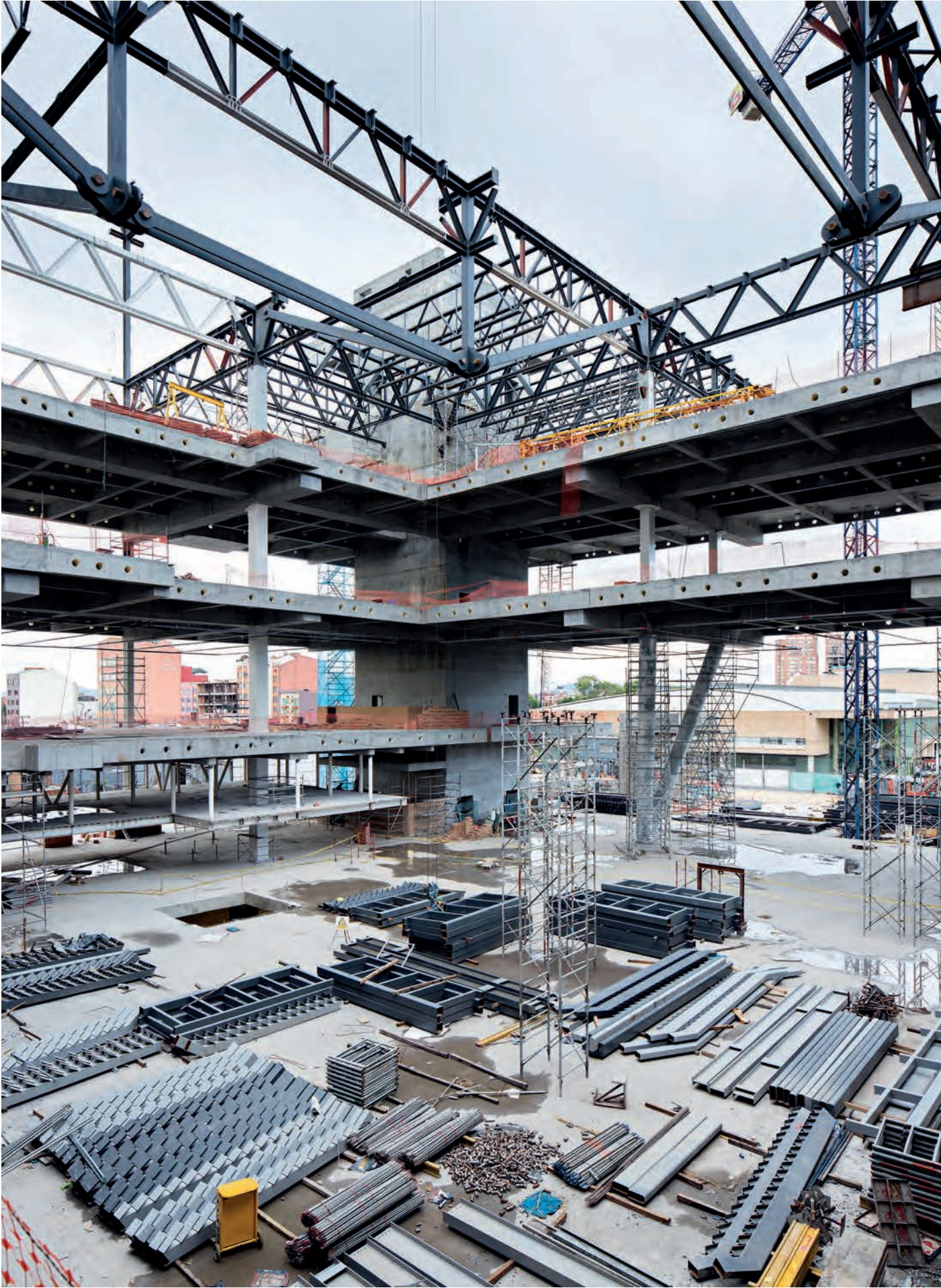
Estructura en construcción. ©Javier Callejas / javiercallejas.com
