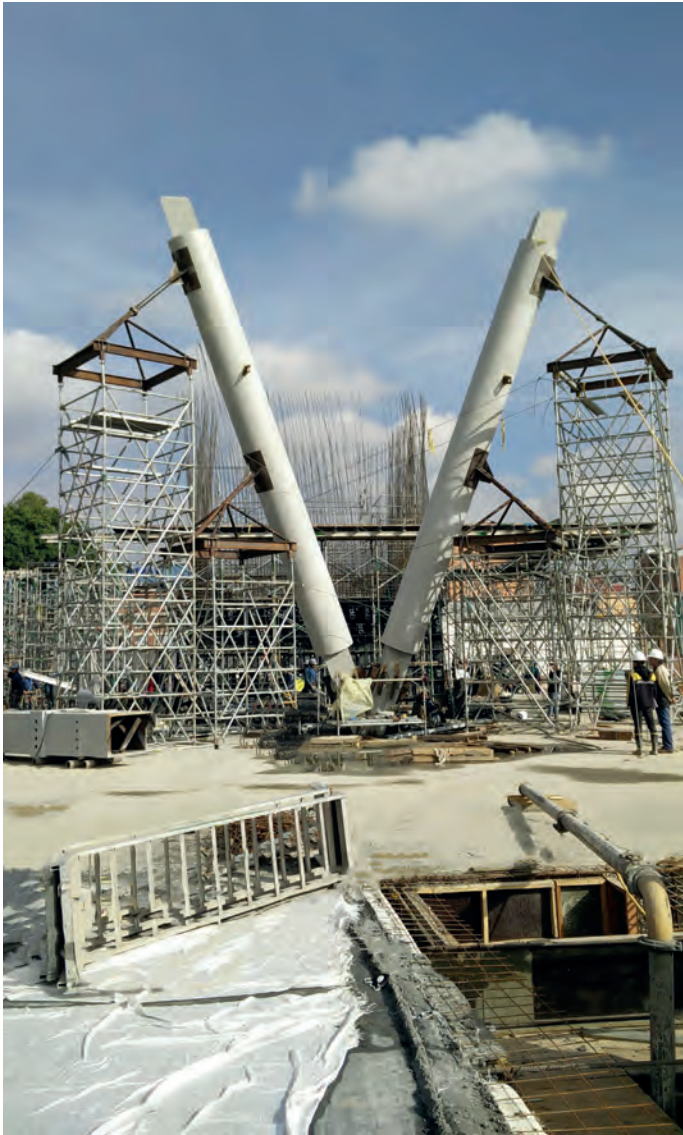
Pilares en V en construcción. ©Bermúdez Arquitectos
