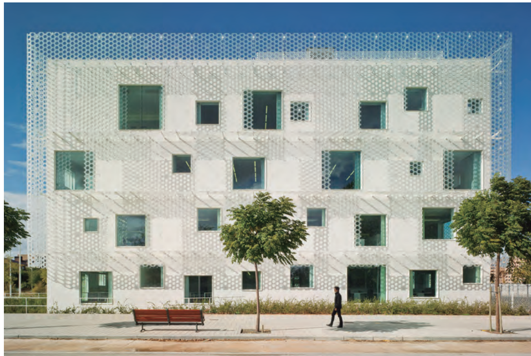
Figura 12. Vista exterior de la fachada suroriental. Fotógrafo: David Frutos Ruiz
