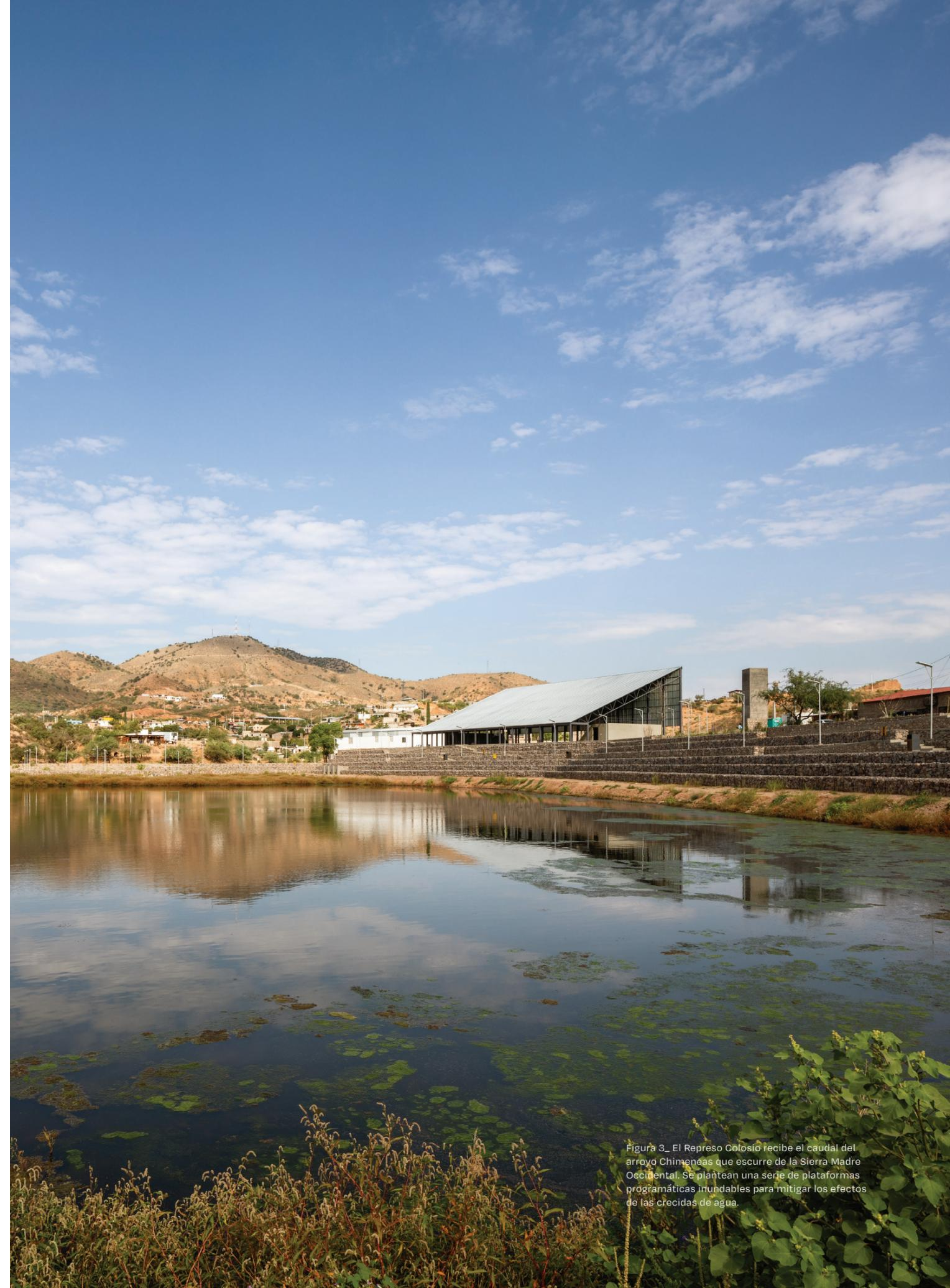
Figura 3\_ El Represo Colosio recibe el caudal del arroyo Chimeneas que escurre de la Sierra Madre Occidental. Se plantean una serie de plataformas programáticas inundables para mitigar los efectos de las crecidas de agua.
