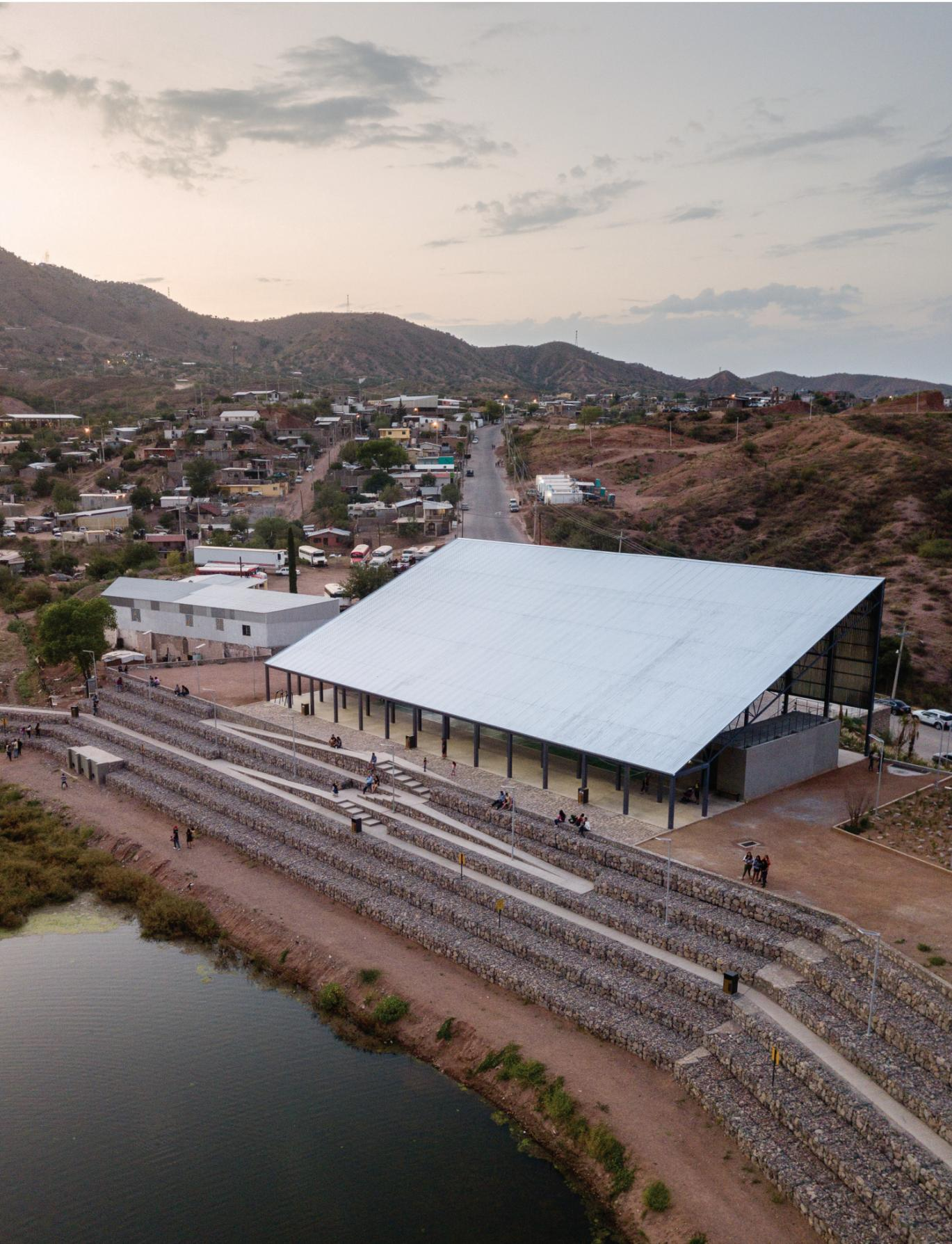
Figura 15\_ Los bordes del represo se refuerzan con gabi6n, conectando plataformas con rampas.
