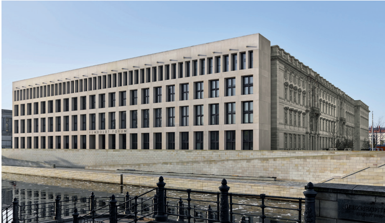
Figura 14_ Vista del nuevo edificio hacia el río Spree y la fachada norte reconstruida.
