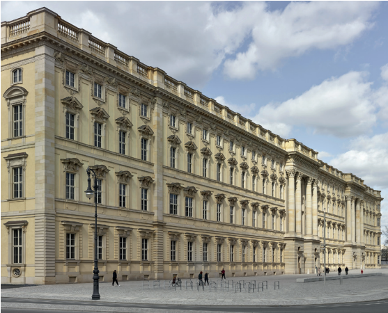
Figura 12_ Vista de la fachada sur reconstruida.
