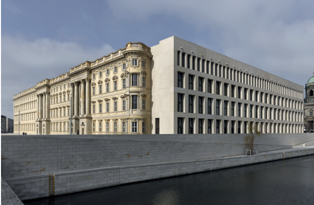
Figura 13_ Vista del nuevo edificio hacia el río Spree y la fachada sur reconstruida.
