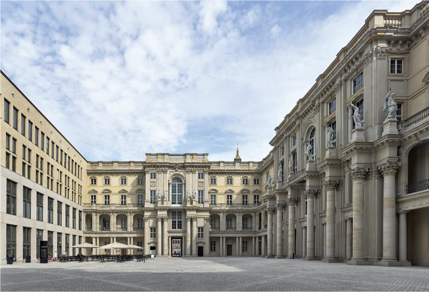
Figura 10_ Schlüterhof (patio este): Vista de las fachadas este y norte reconstruidas y de la nueva fachada oeste.
