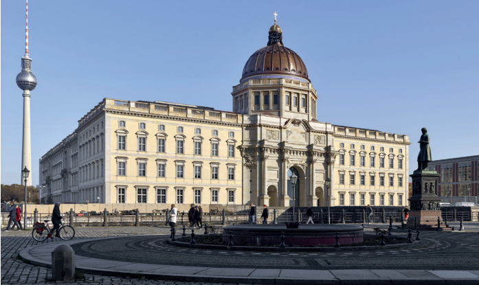
Figura 11_ Vista desde "Unter den Linden" de las fachadas oeste y norte reconstruidas.
