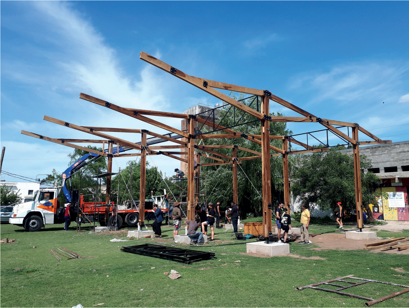
Figura 20_ Se realizó el montaje de la estructura de madera a través de un taller de construcción colectiva que reunió a estudiantes, sus docentes y la comunidad de La Carcova.
