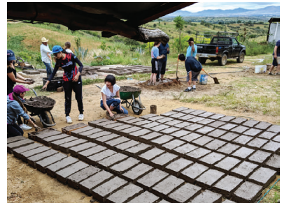
Figura 35_ Secuencia productiva del mezcal, usos de recursos naturales y subproductos de desecho para la elaboración de adobes.
