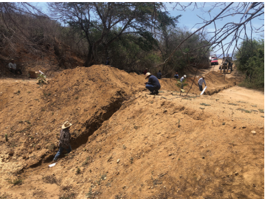
Figura 34_ Sección de sistema de captación y filtración de agua lluvia a través de ollas.
