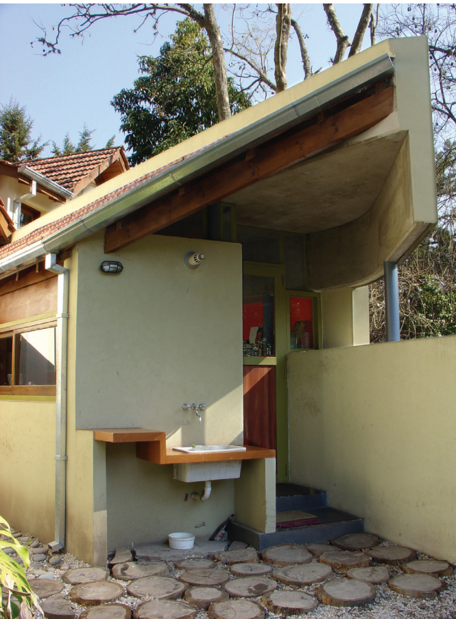
Figura 41_ Vista cocina sector vivienda.
