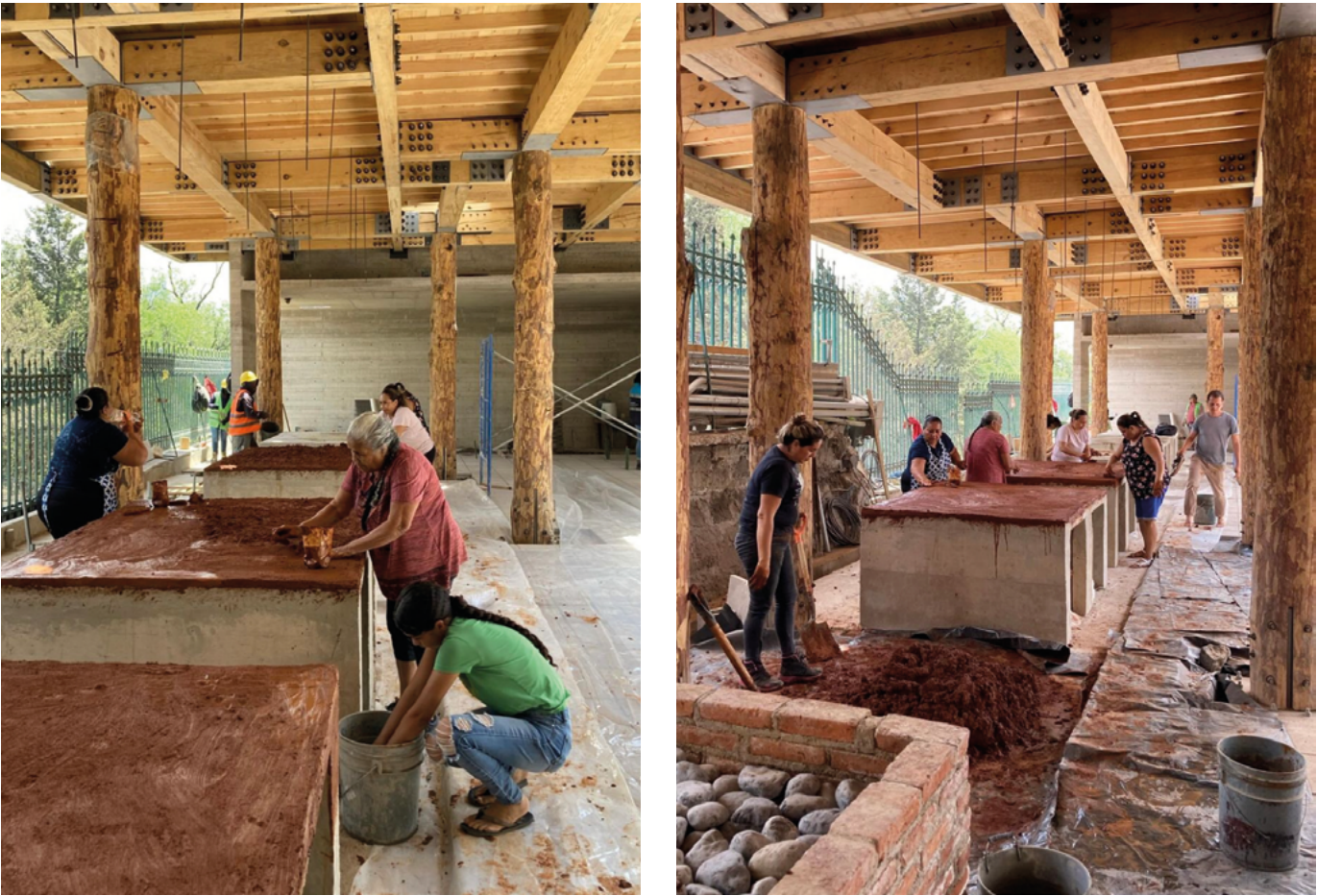
Figuras 6 y 7_ Mujeres de la comunidad de Buena Vista, Guerrero, en proceso de construcción de las chimineas (cocinas tradicionales de humo).
