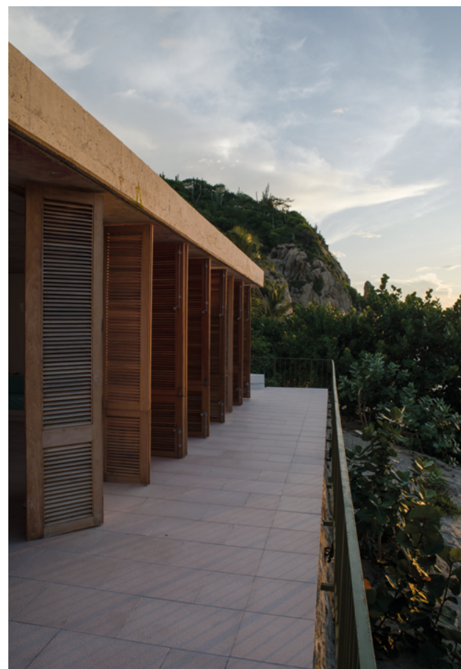
Figura 5_ Vista de la fachada del mar y sus puertas apersinadas en cedro y herrajes en aluminio fundido a mano.
