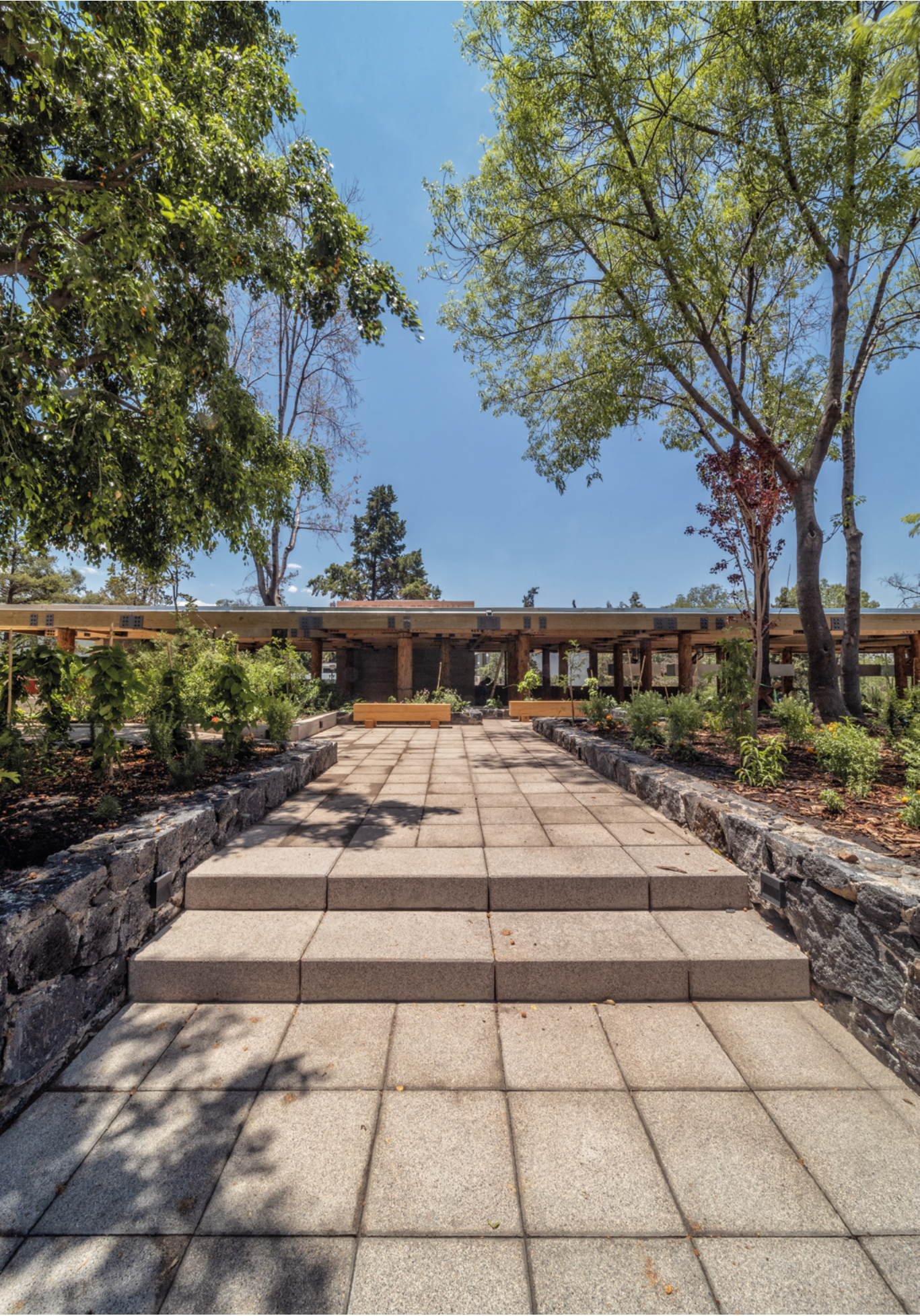
Figura 1_ Vista longitudinal del edificio desde la calzada de acceso.
